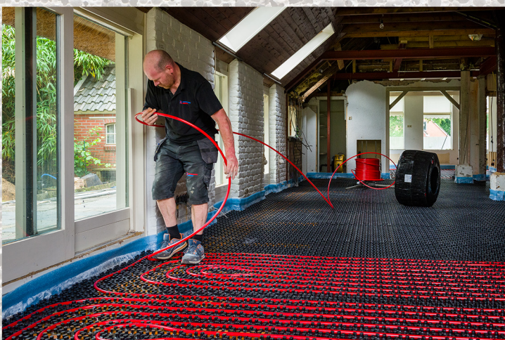
Leidingen vloerverwarming leggen
