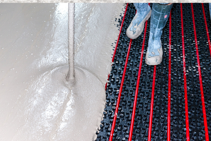
Afwerk gietvloer aanbrengen
