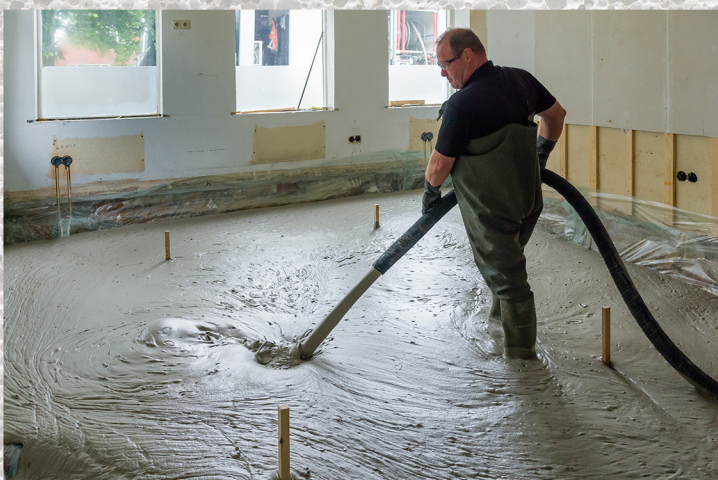
Schuimbeton in kruipruimte
